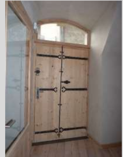
Après travaux, porte d'entrée
