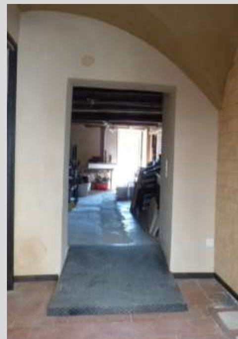
Rampe d'accès handicapées intérieure
