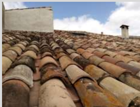
Réfection totale de la toiture
