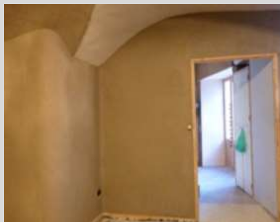
Enduit terre crue, salle de réunion
