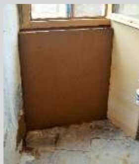
Enduit terre crue
