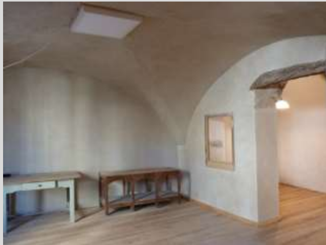
Après travaux, salle de réunion
