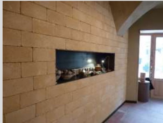
Après travaux, mur en BTC, accueil
