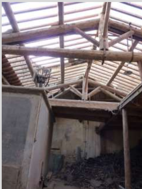
Hangar viticole avant démolition
