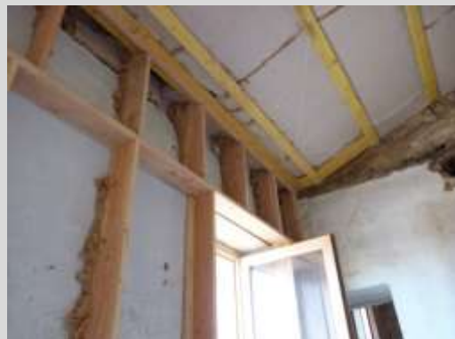
Isolation des murs - Ossature
