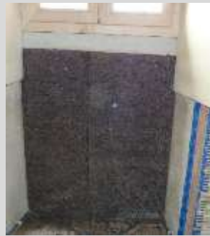
Après pose isolant liège
