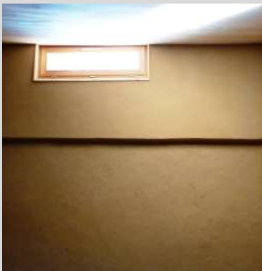
Enduit terre crue
