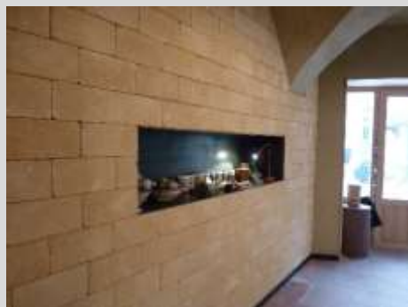
Mur en BTC, accueil
