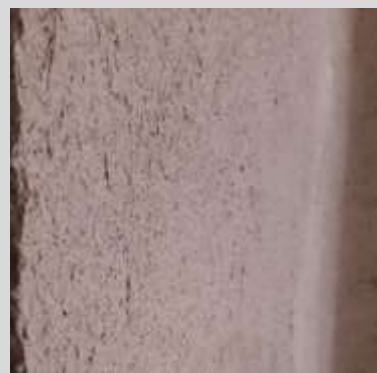
Enduit terre crue + ouate de cellulose
