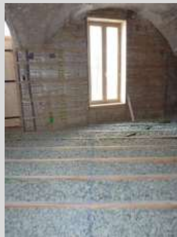
Canisse et isolant verre cellulaire
