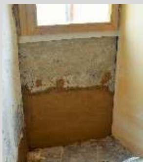
Avant pose isolant
