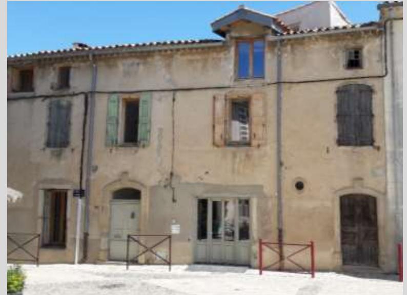
Façade après travaux, modifications des ouvertures
