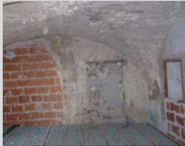
Pendant travaux, salle de réunion
