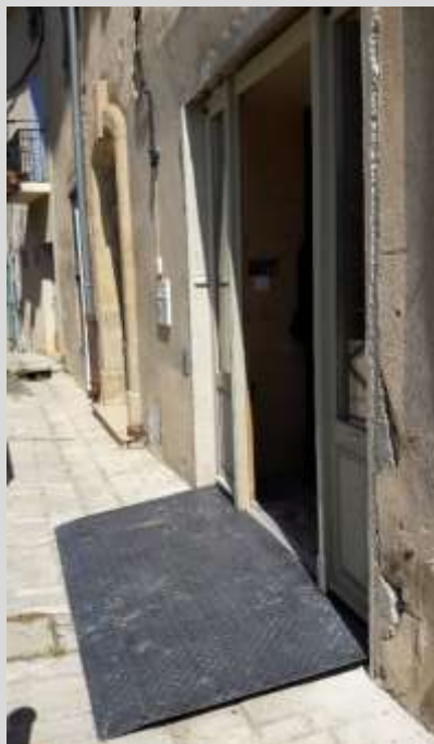
Rampe d'accès handicapées extérieure
