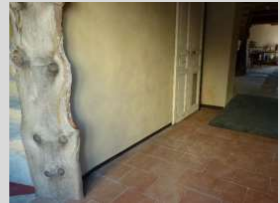
Après travaux, accueil, murs chauffant et porte d'accès au puit
