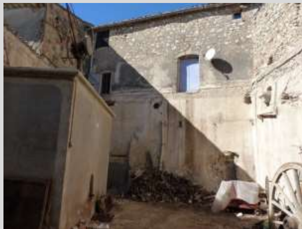
Hangar viticole après démolition
