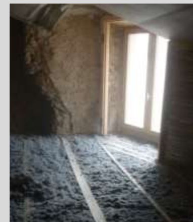
Ouate de cellulose en plancher
