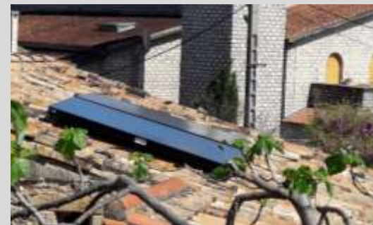
Capteurs solaire 2 x 2m 2
