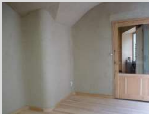
Après travaux, salle de réunion, murs chauffant
